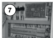
7 Terminalkasten innen Reguläre interne Verdrahtung zur bequemen Wartung verbindend
